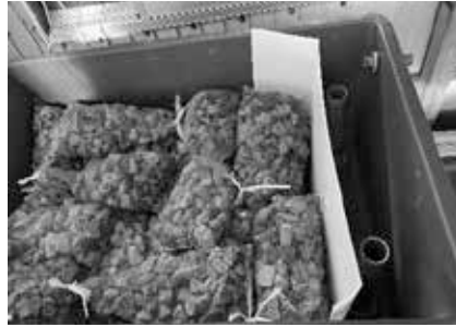
ろ過槽の作成
