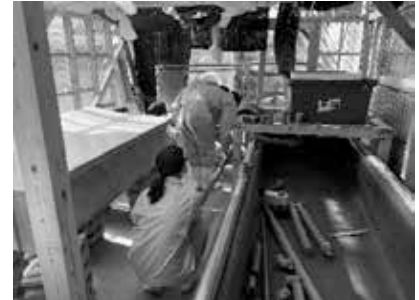
水槽の配管を配置
