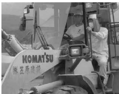
重機操作を体験する様子
