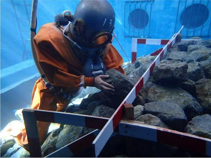
港の防波堤などに使用されるケーソンなどの構造物を、安定して設置するためには基礎が必要となる。基礎の材料の石を工事の目安になる遣り方定規に合わせて、平らに均すことを「石均し」という。写真では送気式潜水器の1つであるヘルメット式潜水器を使用している。他には全面マスク式潜水器も有していて、どちらも陸上との通信を取りながらの実習が可能である。
