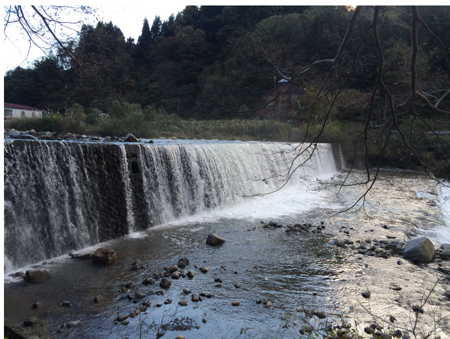
写真3 魚道が付帯されている頭首工の観察
